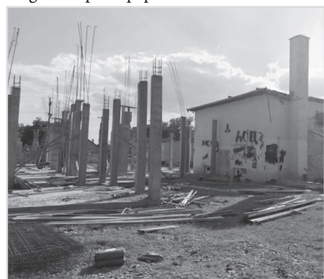
A telepi iskola felújítása folyamatosan zajlik
